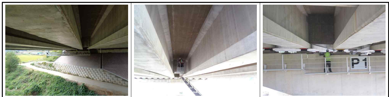
[고소작업차, 굴절점검차를 이용한 근접조사 실시]
