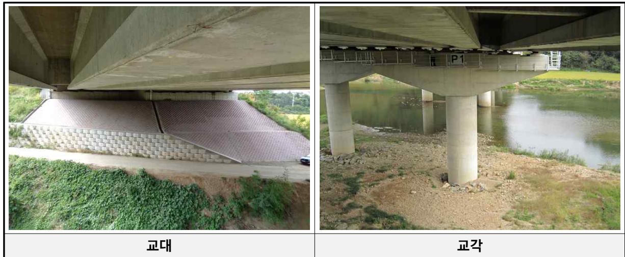
[교대 및 교각 전경]
